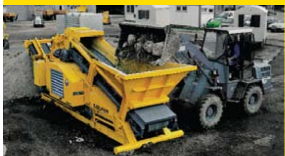
Переработка различного строительного лома, асфальта, кирпича и железобетона
