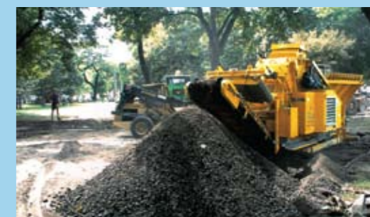
Использование дробильной установки RM60 при работах по благоустройству в природоохранных зонах и в городской черте
